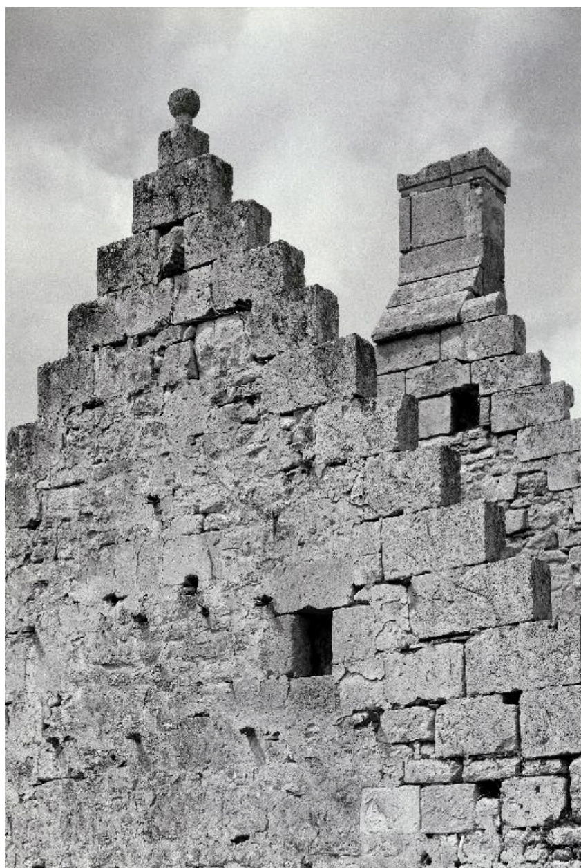
Détail de pignons à redents, à Vivières.
