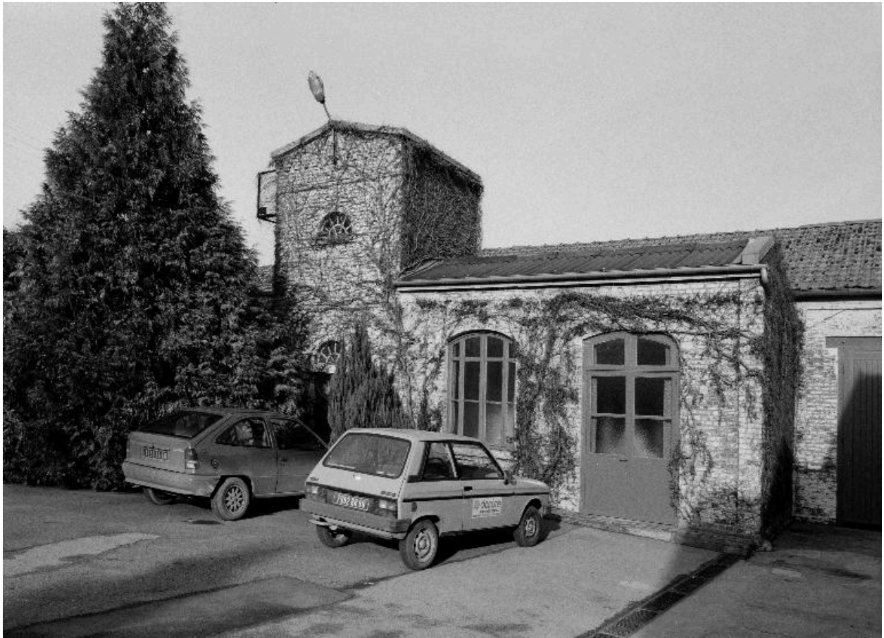
Transformateur. Élévation antérieure.
