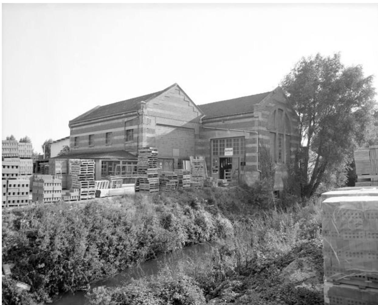
Ateliers de fabrication, vue partielle, flanc nord.
