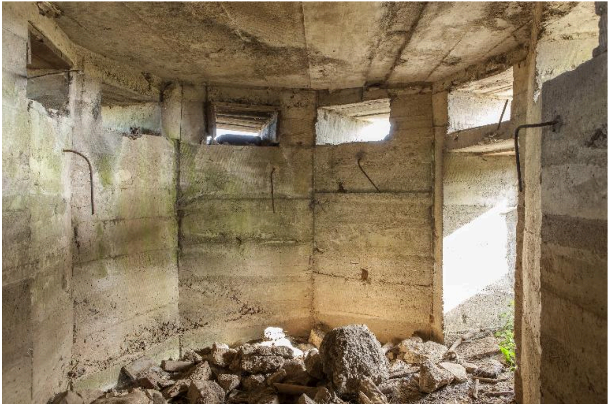
Vue intérieure, vers le nord
