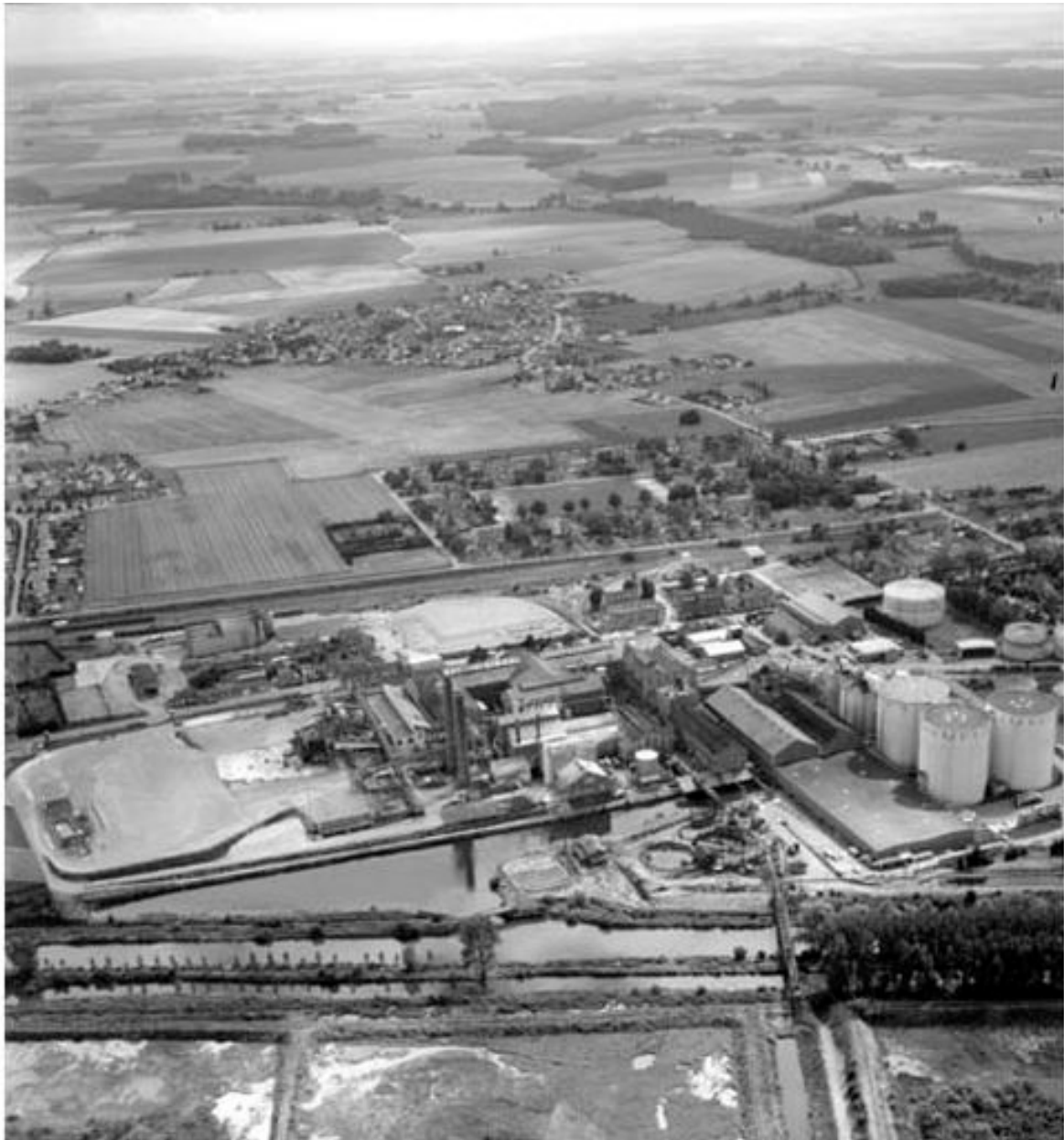
Vue aérienne flanc est de l'usine.
