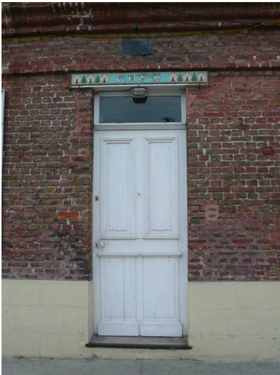
Vue détaillée d'une entrée de café à Favières.
