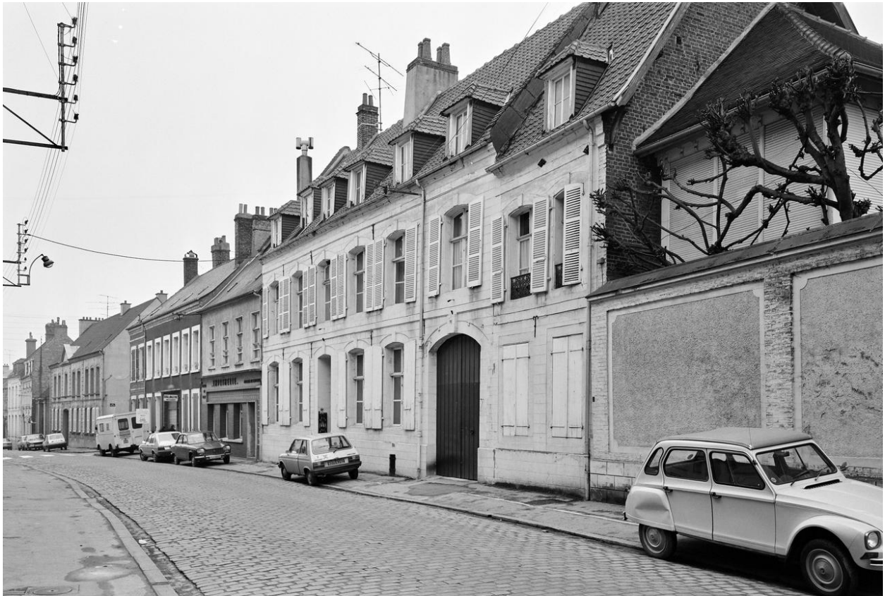
Vue générale prise depuis la rue.
