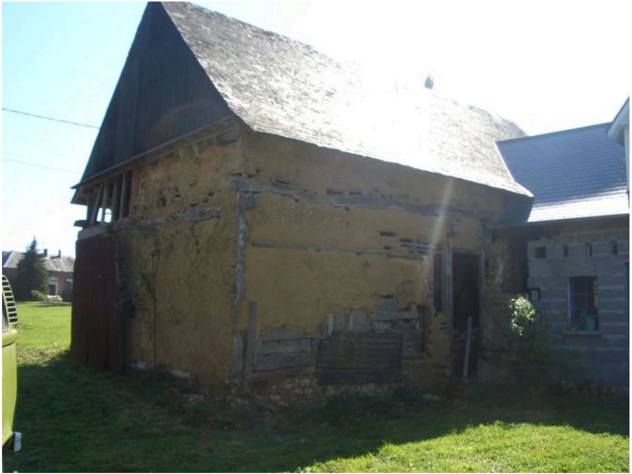
Vue de la grange sur rue.
