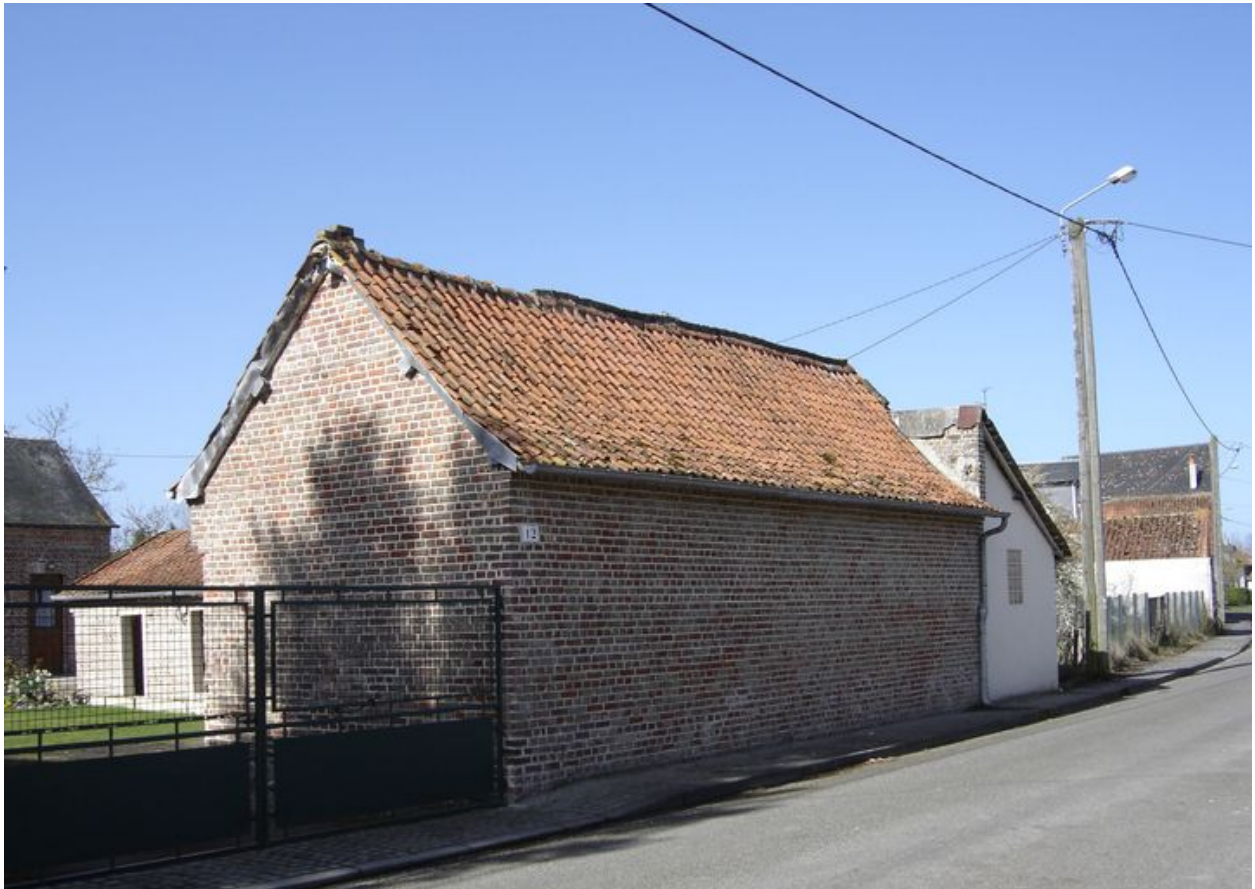
Vue postérieure des étables à vaches.
