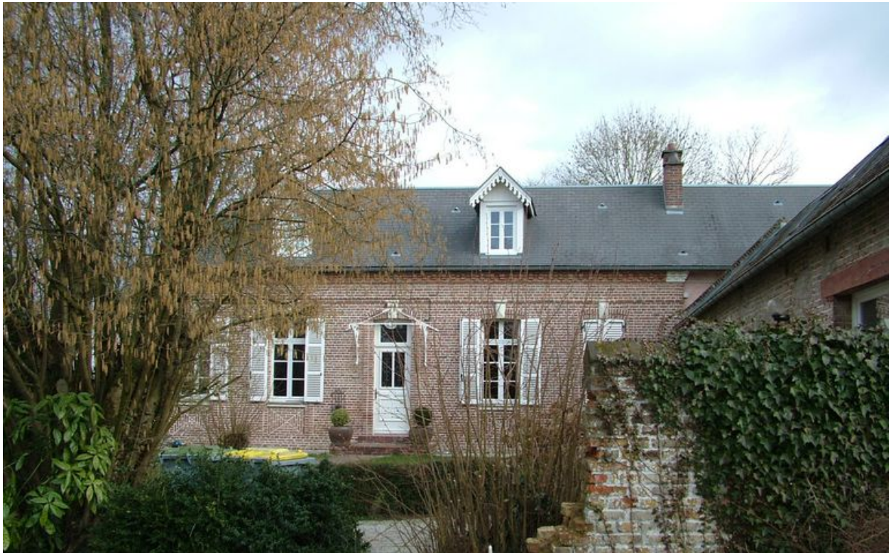
Vue de la maison depuis la cour.
