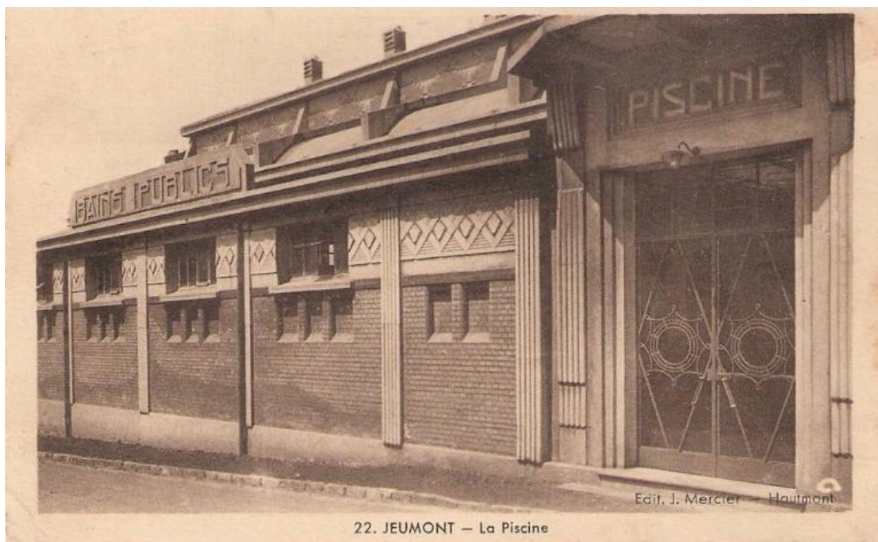
Jeumont (Nord), façade d'entrée de la piscine construite en 1927 par Adolphe Danis, carte postale, vers 1930 (coll. part.).
