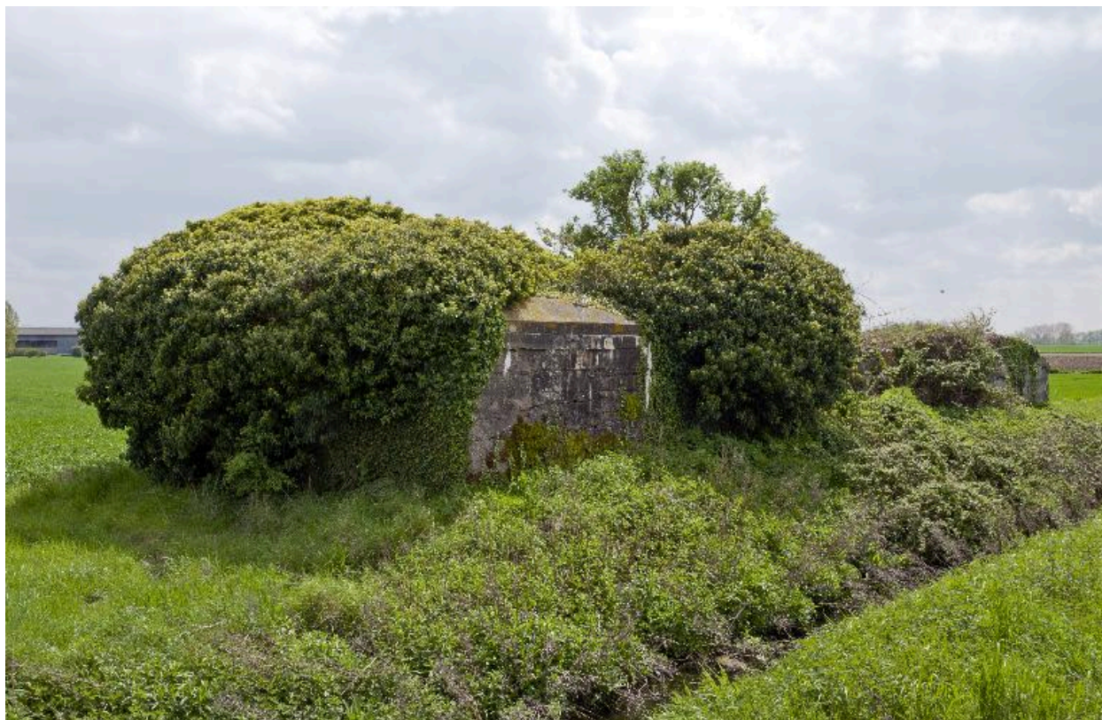
Le bâtiment B, vers le sud, le long du ruisseau
