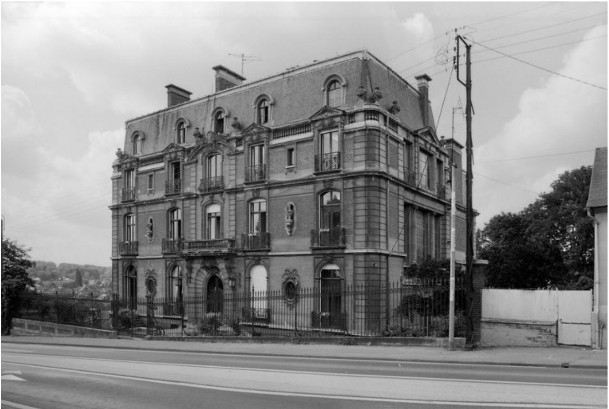
Façade principale sur la rue Courbet, en 1991.
