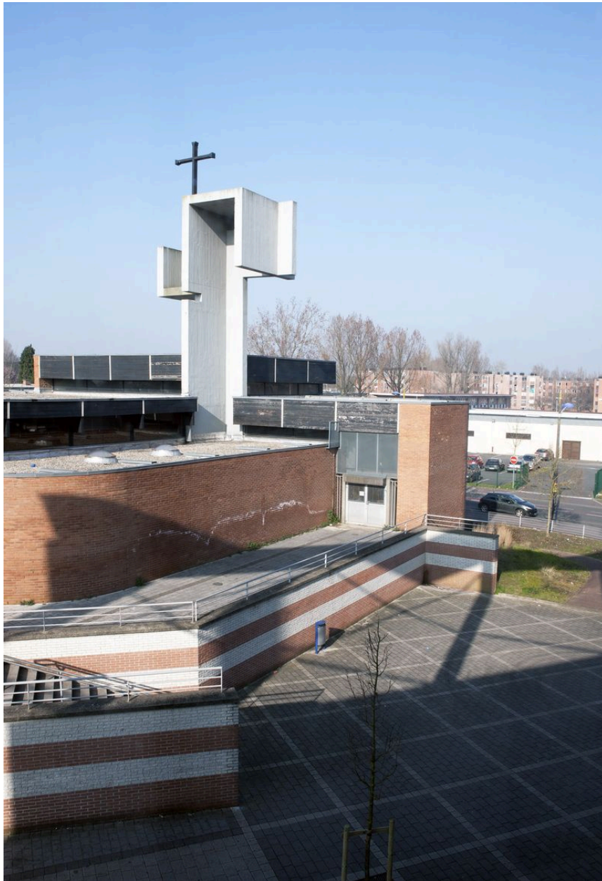
Vue de trois quart du flanc droit de l'église.
