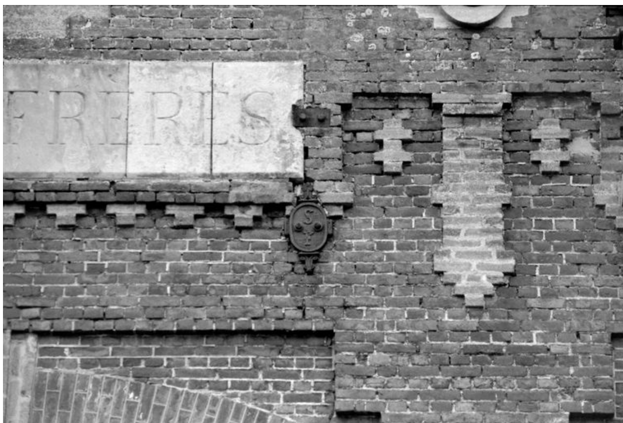
Détail de la façade de la salle des machines, en 1988.
