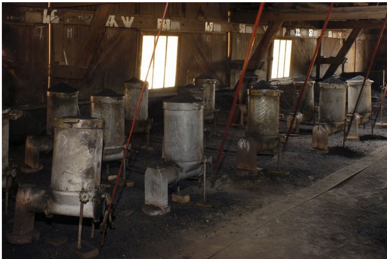
Vue des récipients à charbon, dits marmites à charbon, au-dessus des foyers du four.
