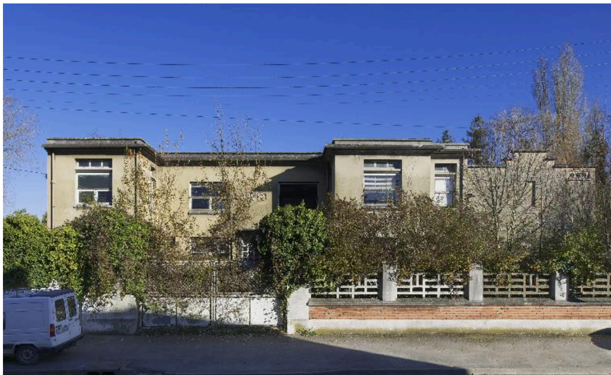
Façade sur rue (ouest) des bureaux.
