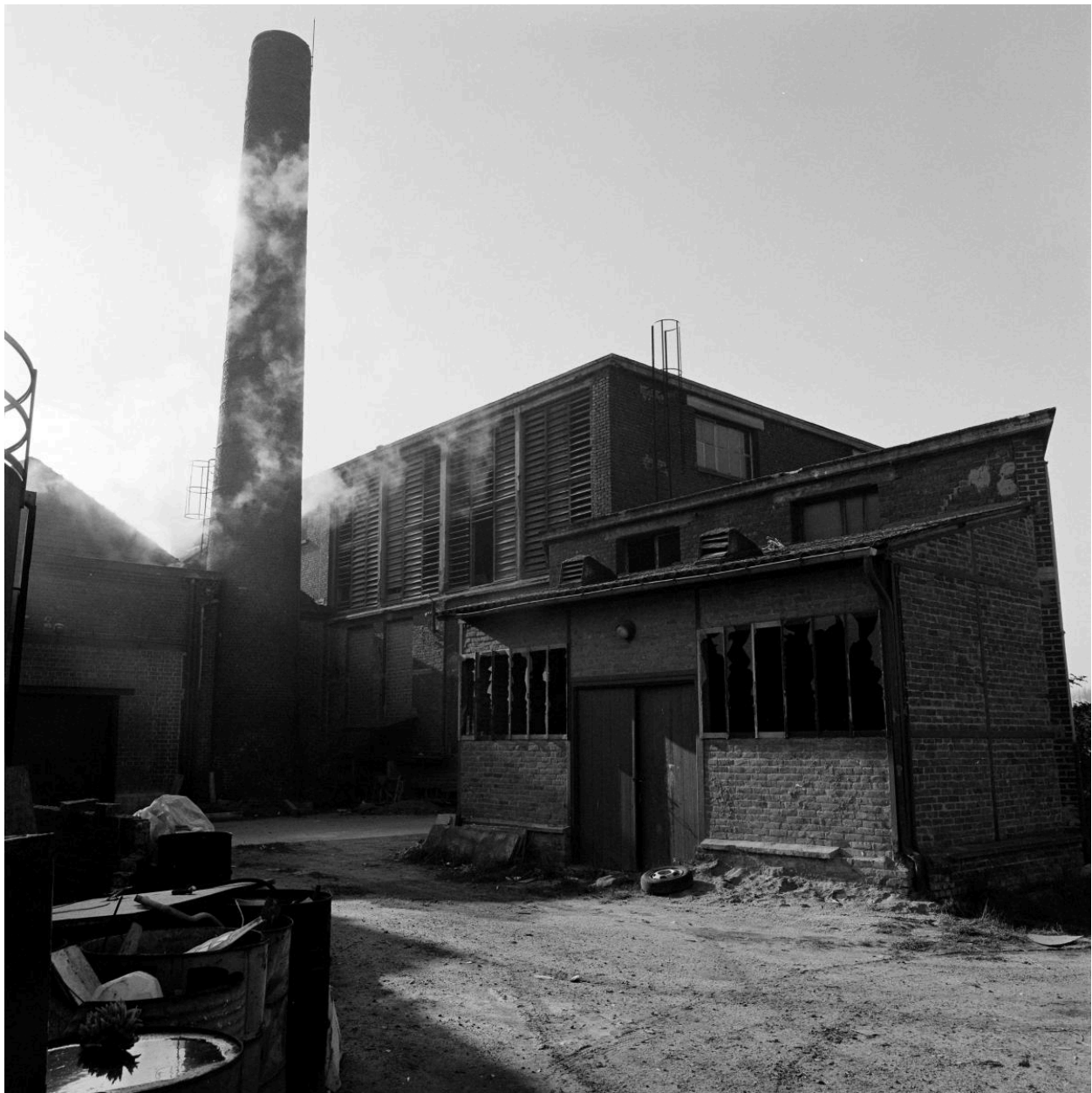
Magasin des toiles, atelier de fabrication, vers le sud.
