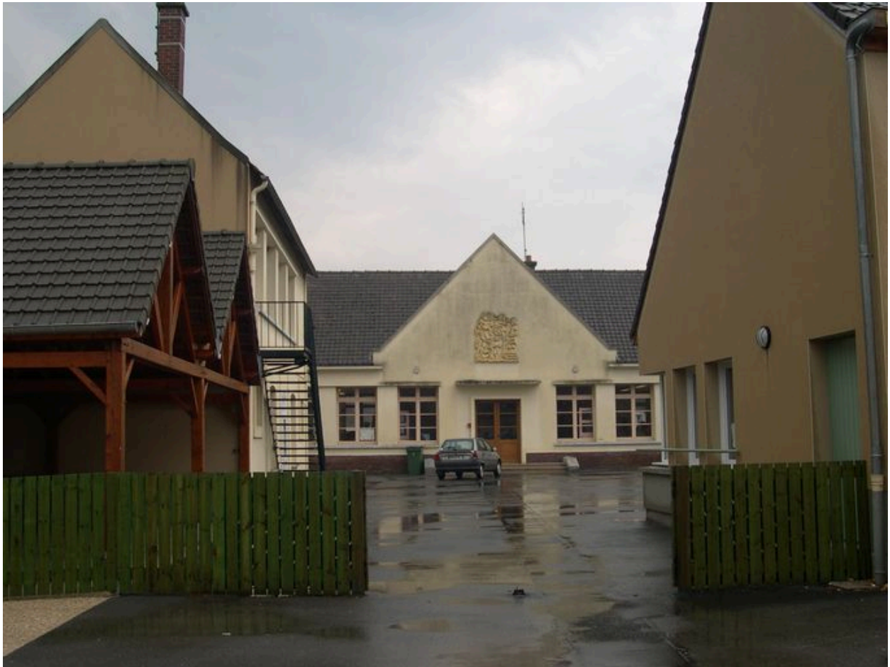
Vue de l'école, depuis le nord.
