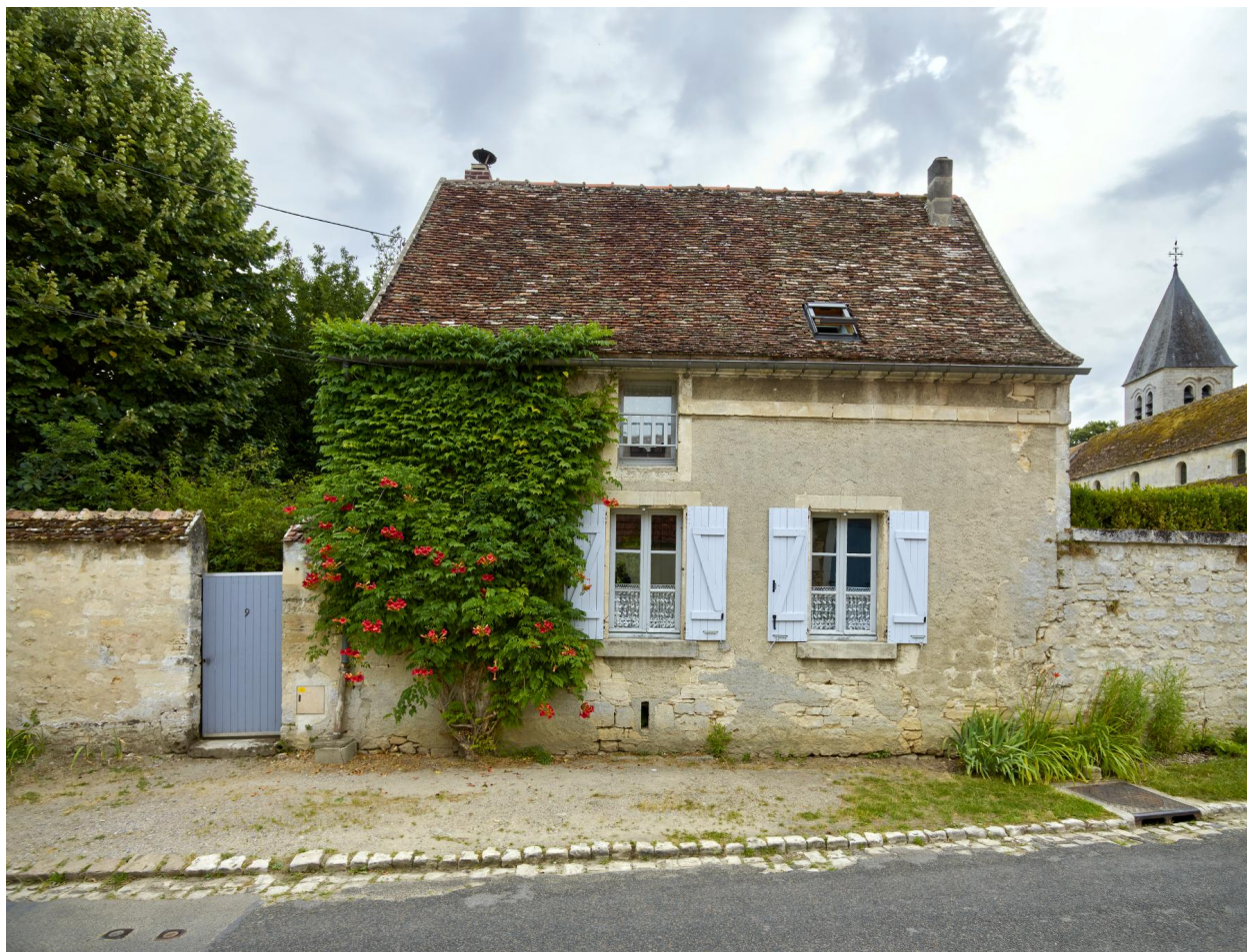
Vue de l'ouest de la façade sur rue de la maison de vigneron.
