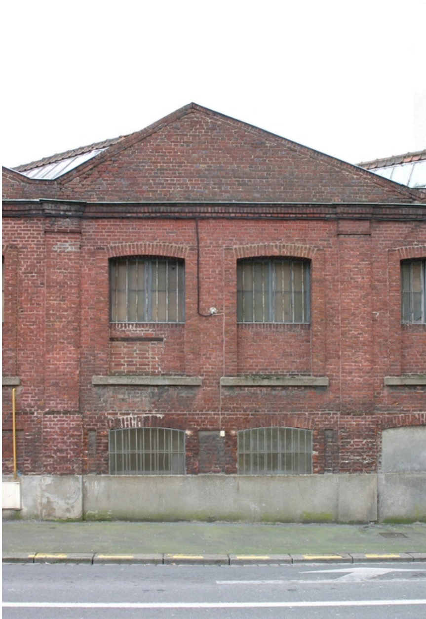
Détail de façade, rue des Glacis.
