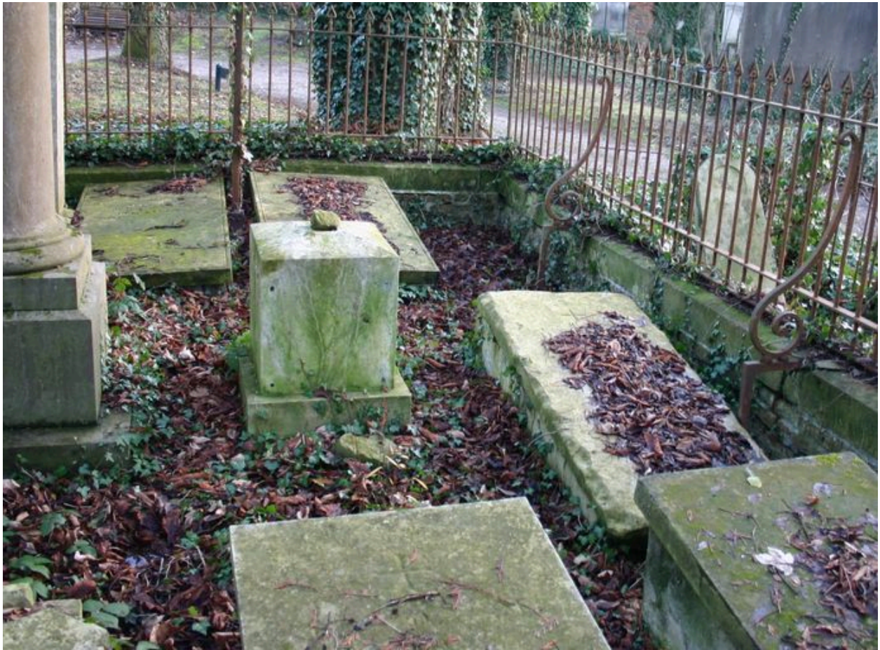
Base de la croix funéraire (disparue) et dalles funéraires sur soubassement en palis.
