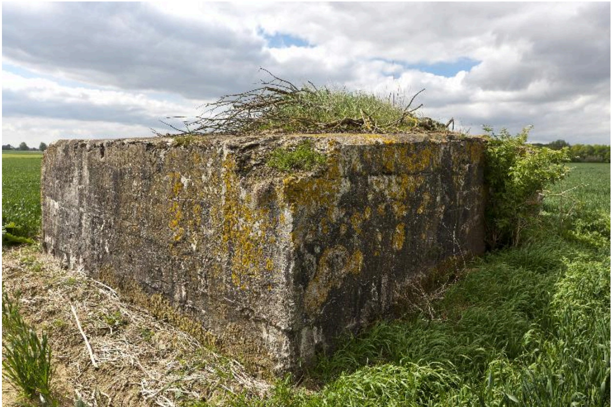
Angle nord de l'édifice. A droite, derrière la végétation, l'ouverture de tir.
