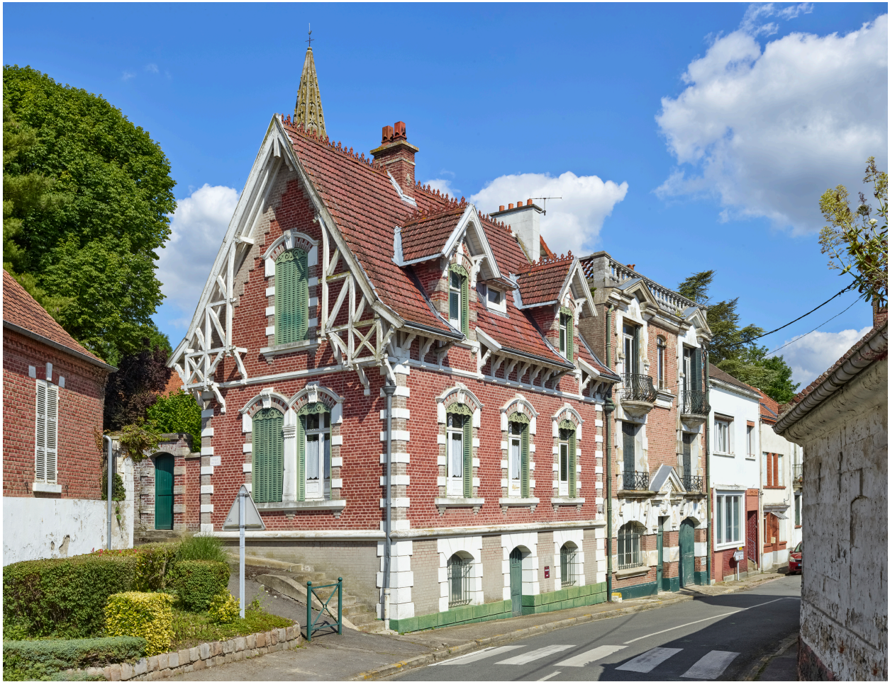
Vue d'ensemble de la villa, depuis le sud-est.
