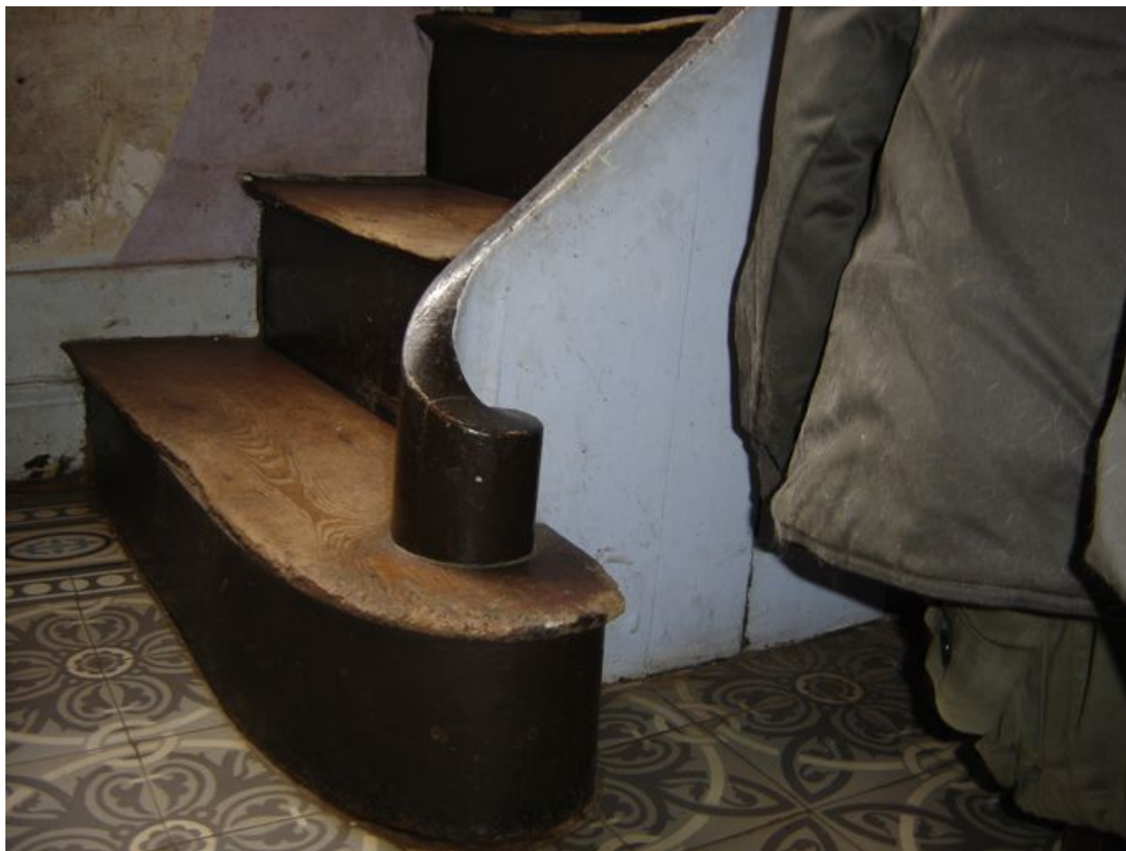
Vue du bas de l'escalier.
