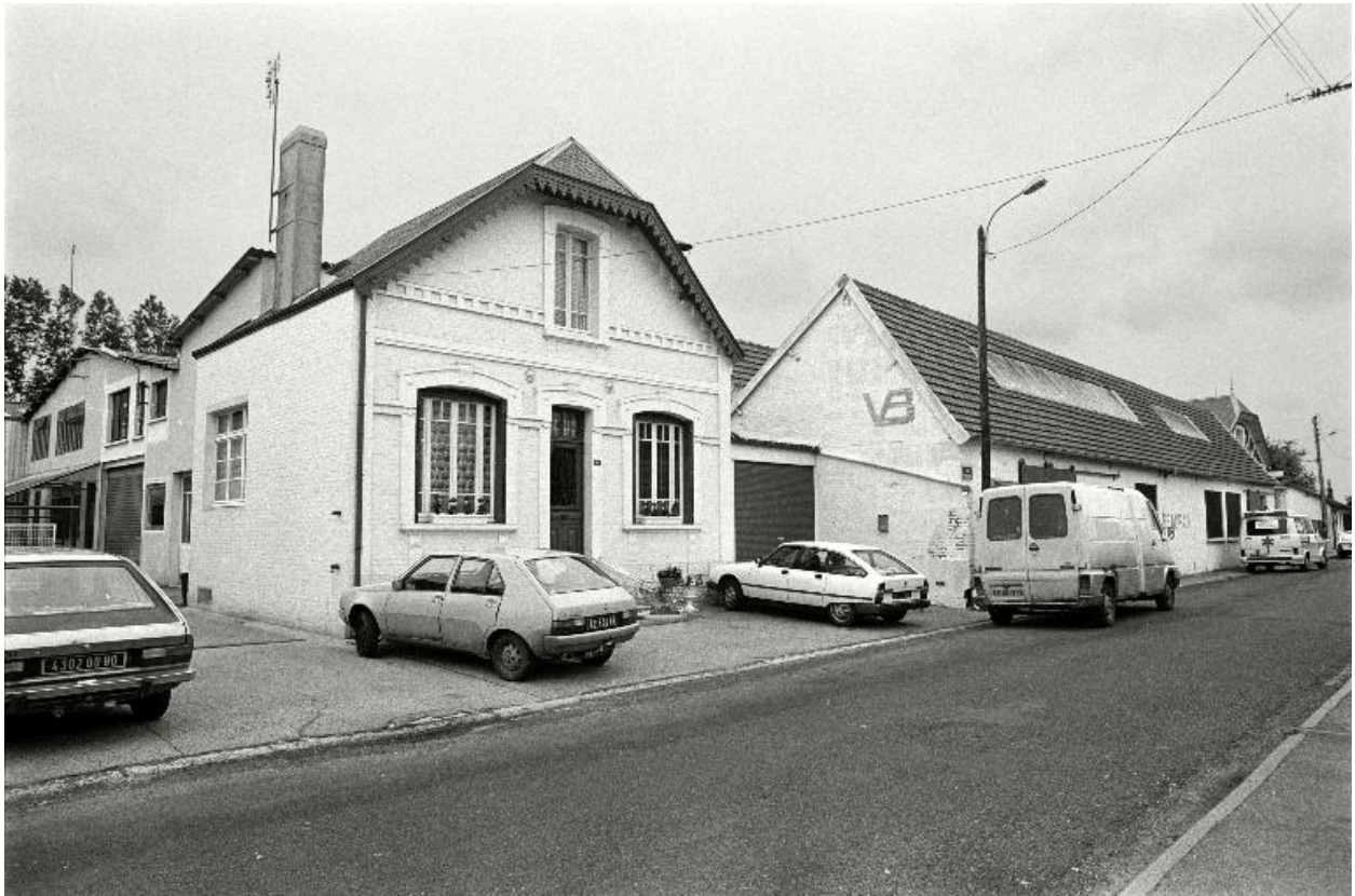
Bureau et atelier de fabrication.
