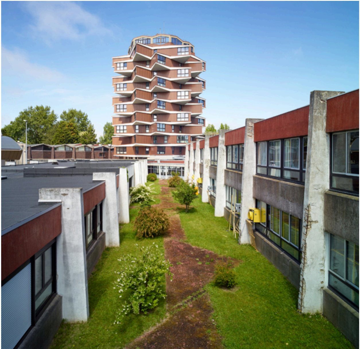
Vue générale du patio central sud ouest et de l'élévation de la tour de l'internat, depuis la toiture du C.E.T.
