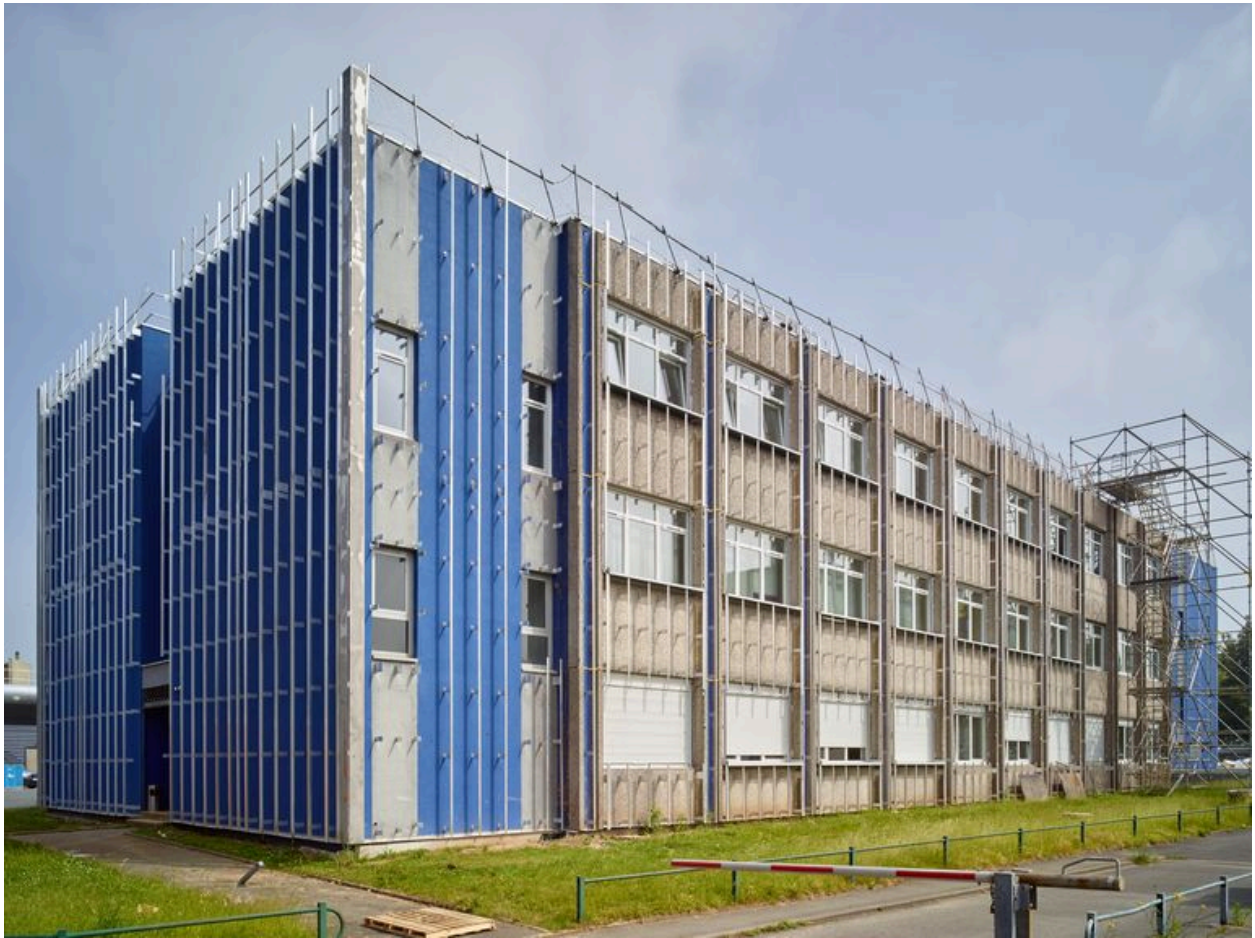
Le centre de formation depuis le nord-ouest, en cours de rénovation.
