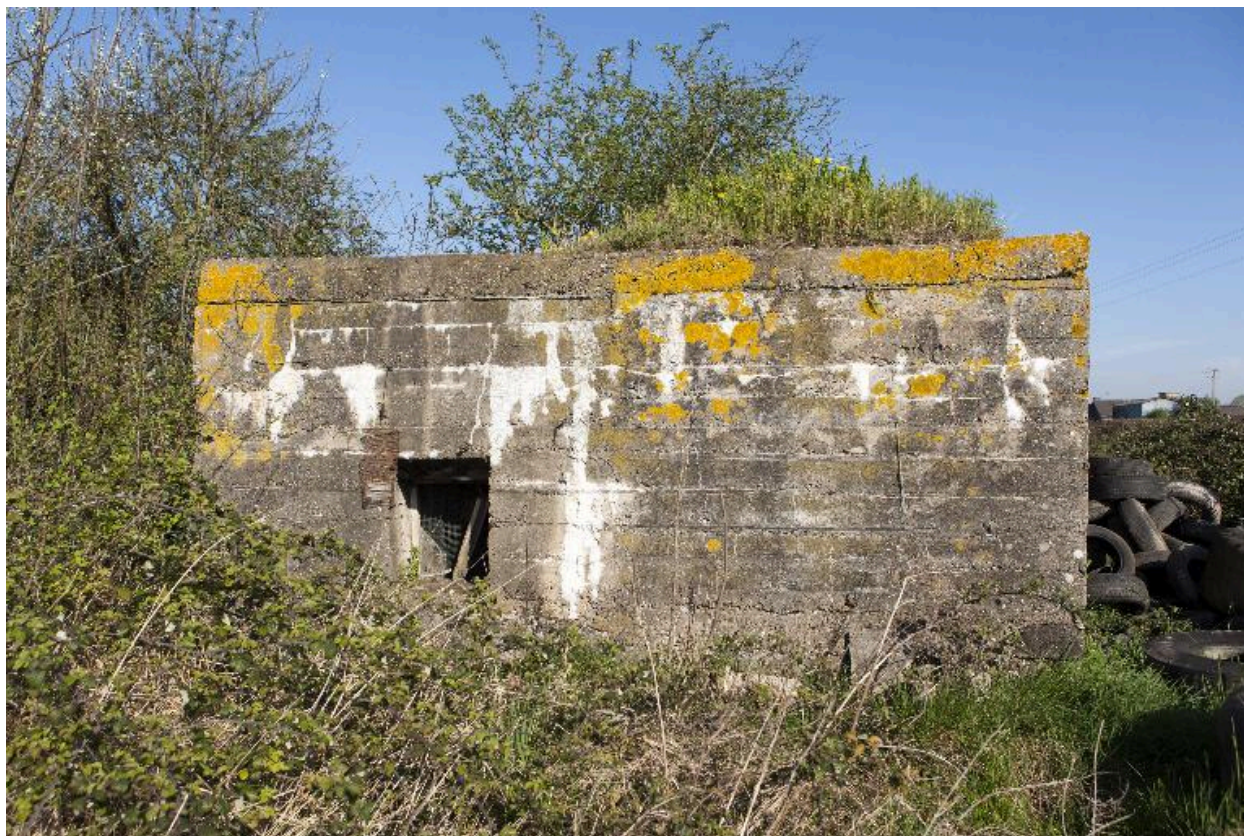
Casemate B, fenêtre sur l'élévation sud
