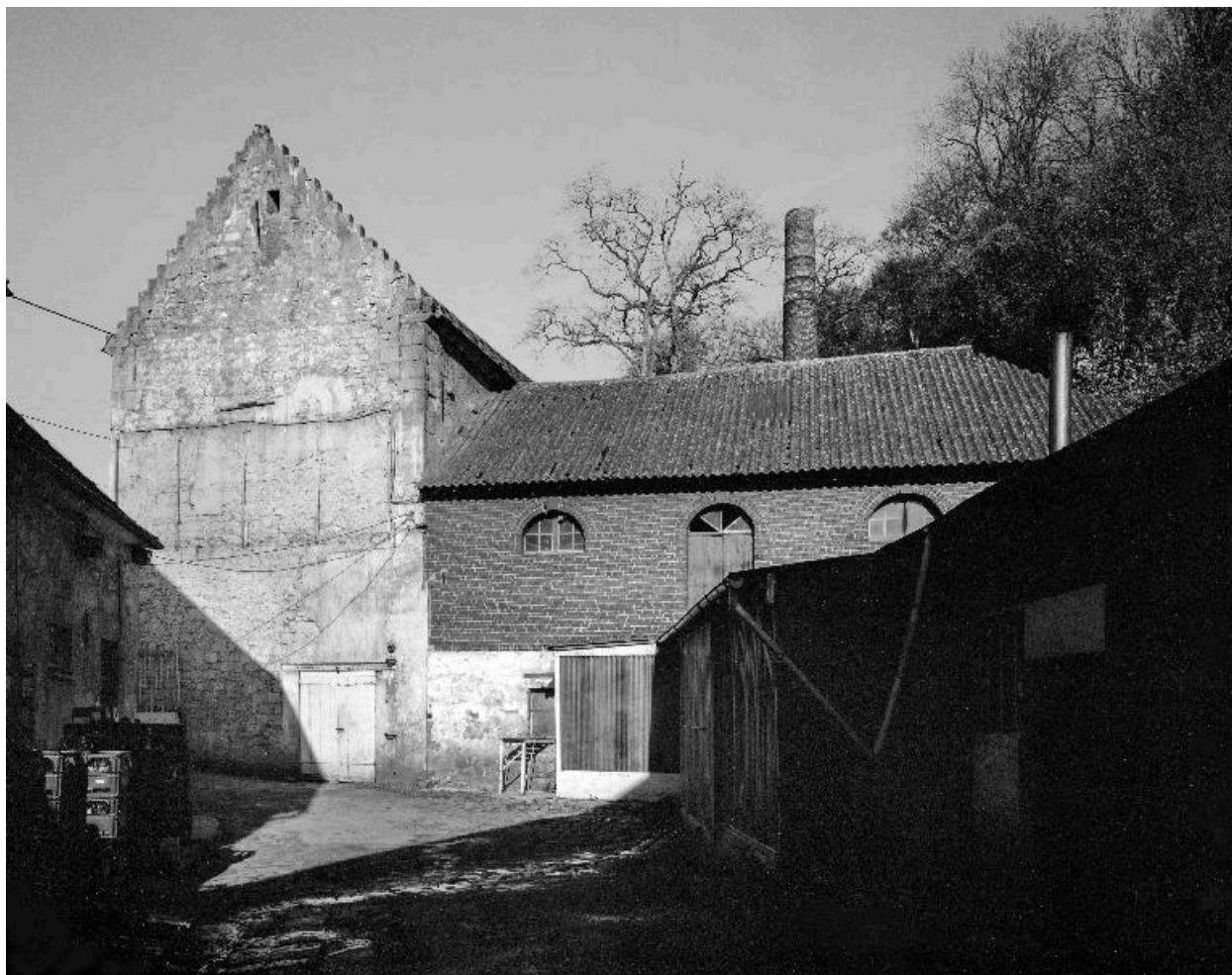
Élévation sur cour de l'atelier de fabrication.
