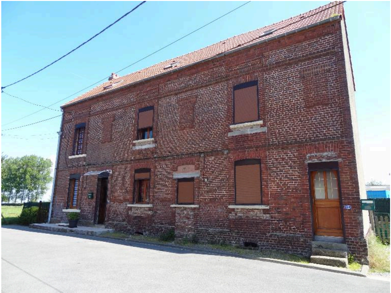
Vue générale des logements sud depuis l'impasse Gabriel Péri.
