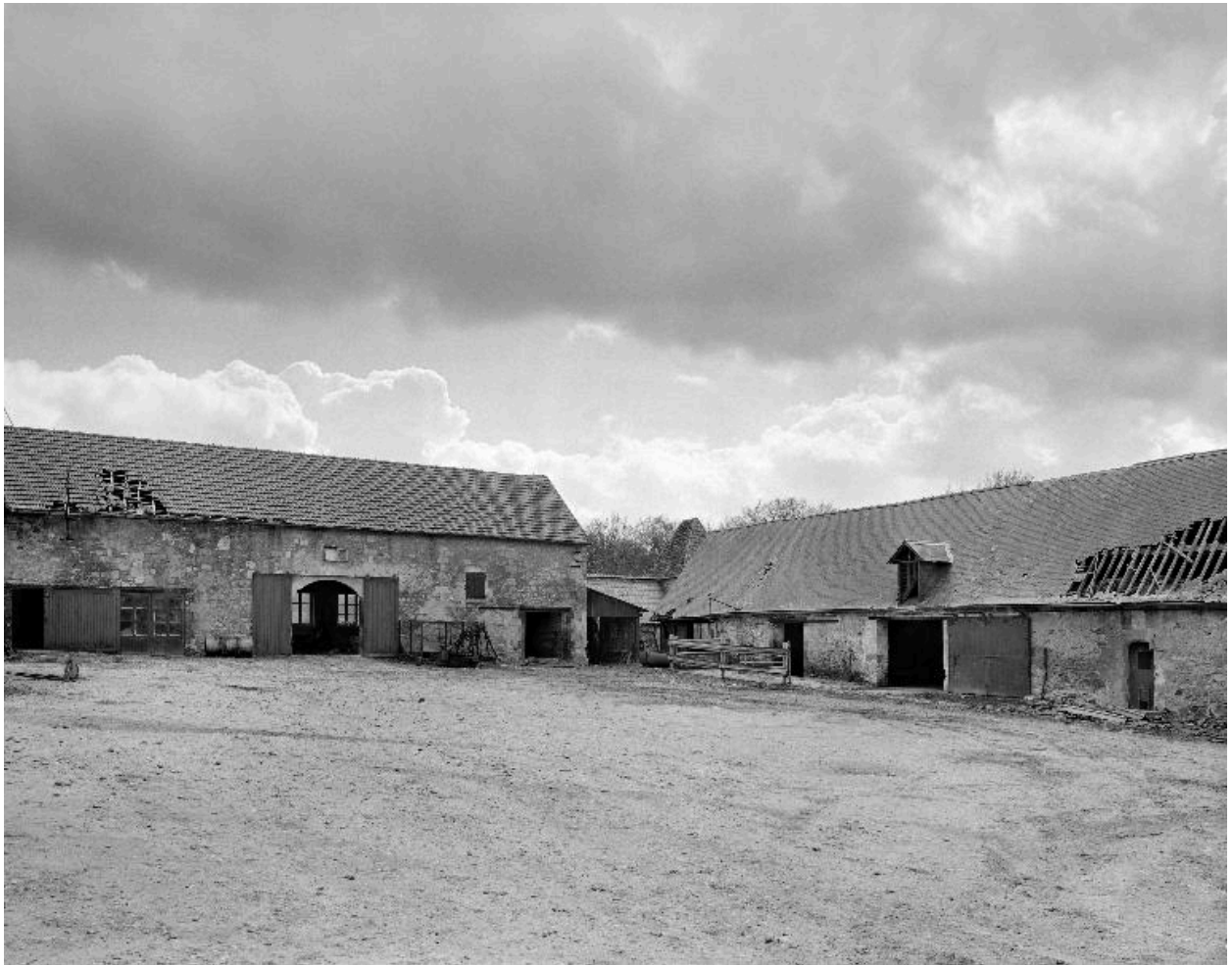
Bâtiments formant l'angle sud de la ferme : élévations sur cour.
