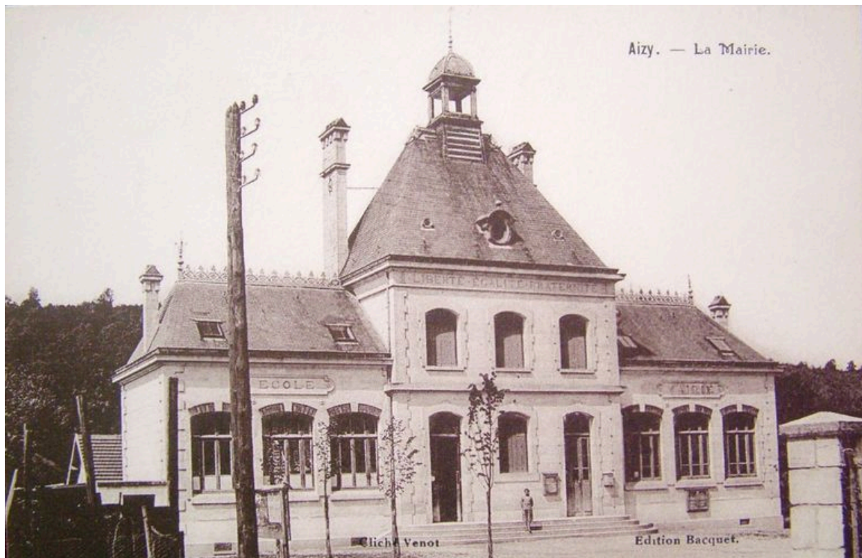
Vue de l'édifice après sa reconstruction (coll. part).
