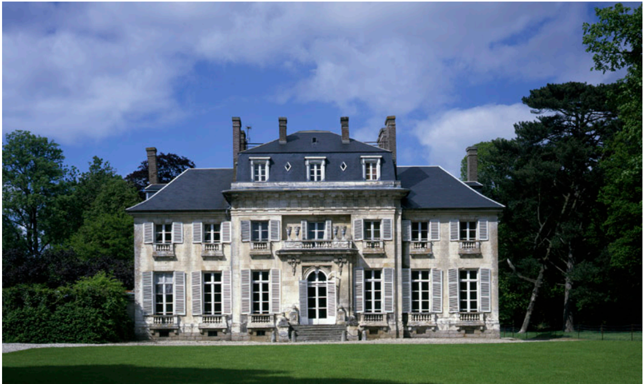
Elévation sud (façade sur cour) : vue de face.
