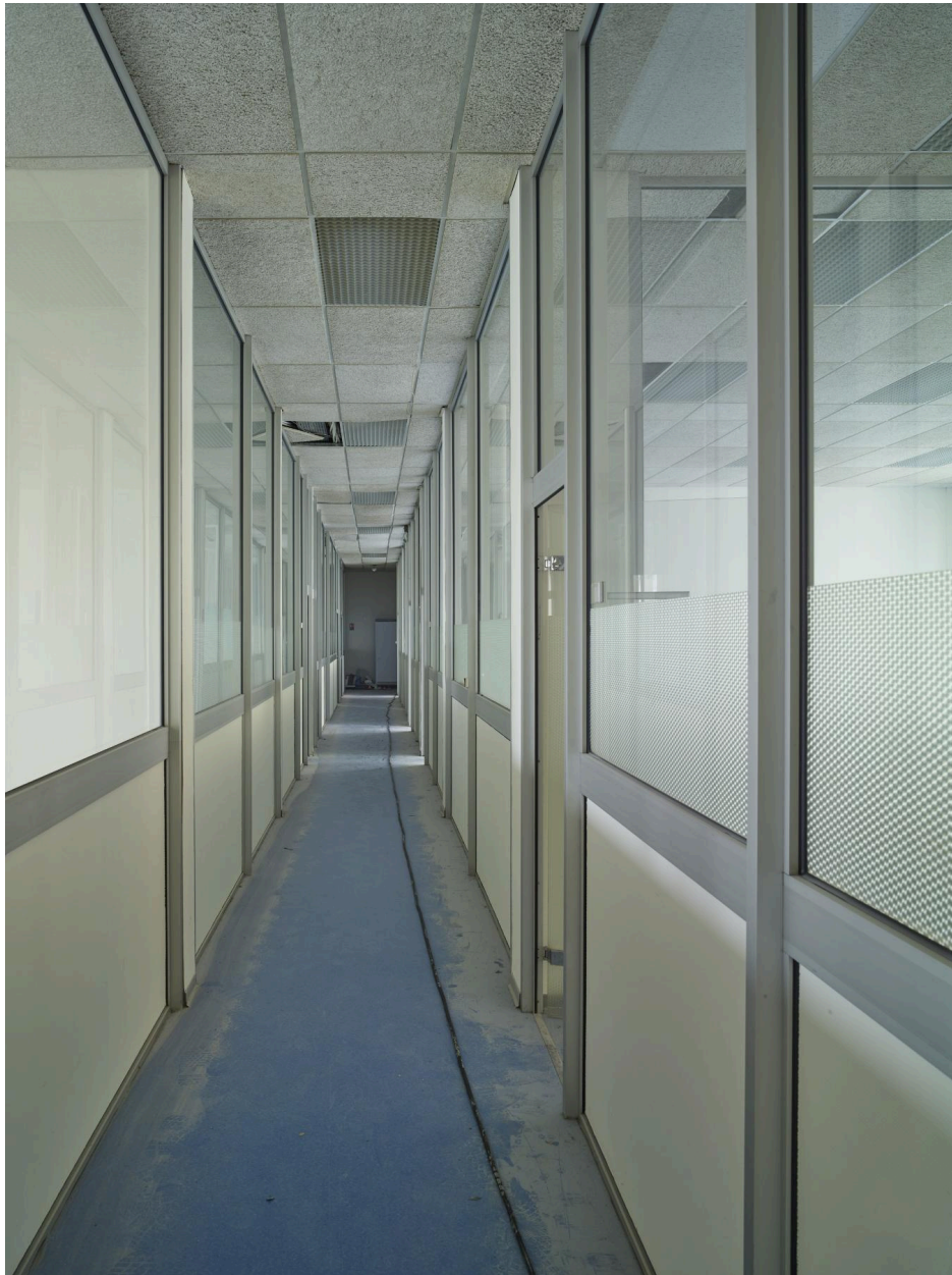
Rez-de-chaussée, couloir de distribution des bureaux de la CPAM.
