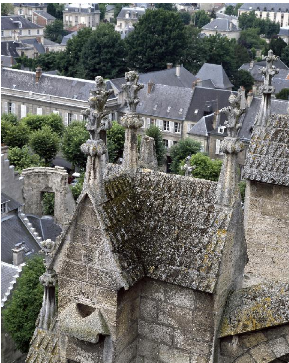
Partie supérieure de la culée d'un arc-boutant de la nef.
