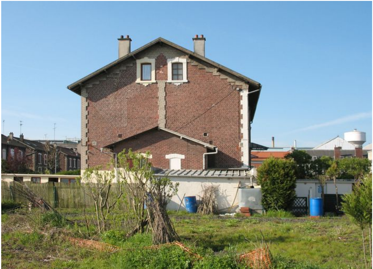
Mur pignon de deux logements de la cité Mertian.
