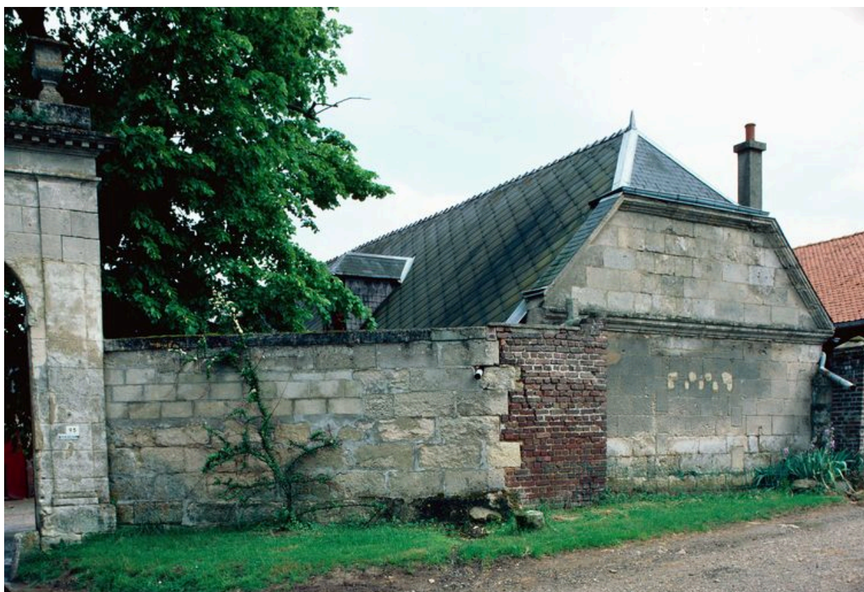
Grange. Pignon sur rue.
