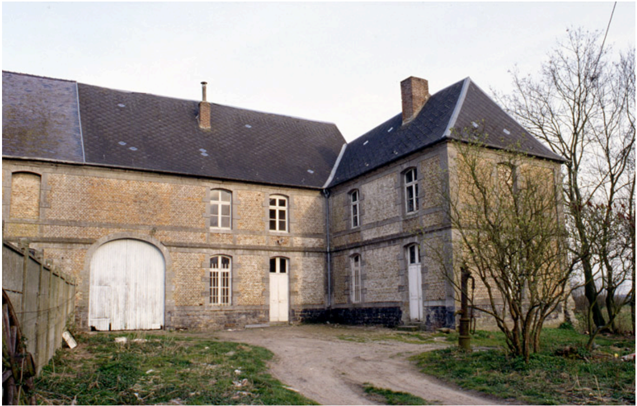
Vue partielle de l'élévation ouest des bâtiments subsistants.
