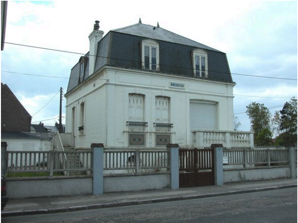
Vue d'ensemble depuis l'avenue Paul-Doumer.
