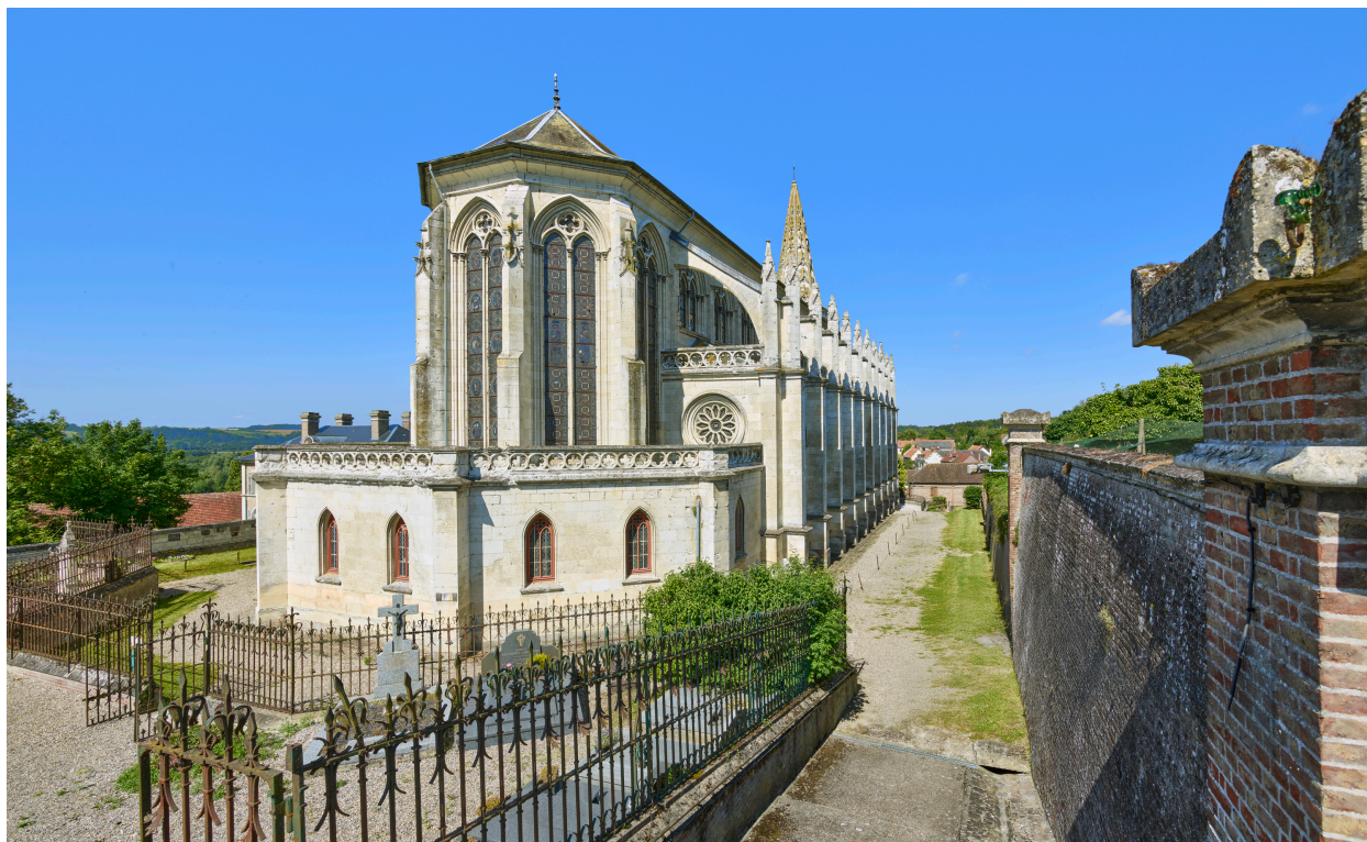
Vue nord-est de l'église, depuis le cimetière.
