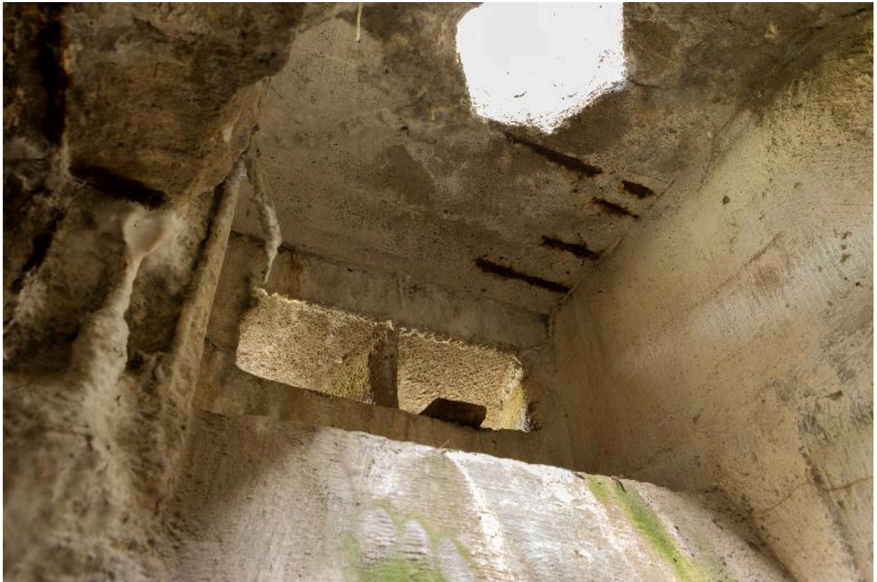
Casemate b. Vue intérieure de l'observatoire bétonné. Passage du périscopes et embrasures de surveillance, vers nord-ouest.
