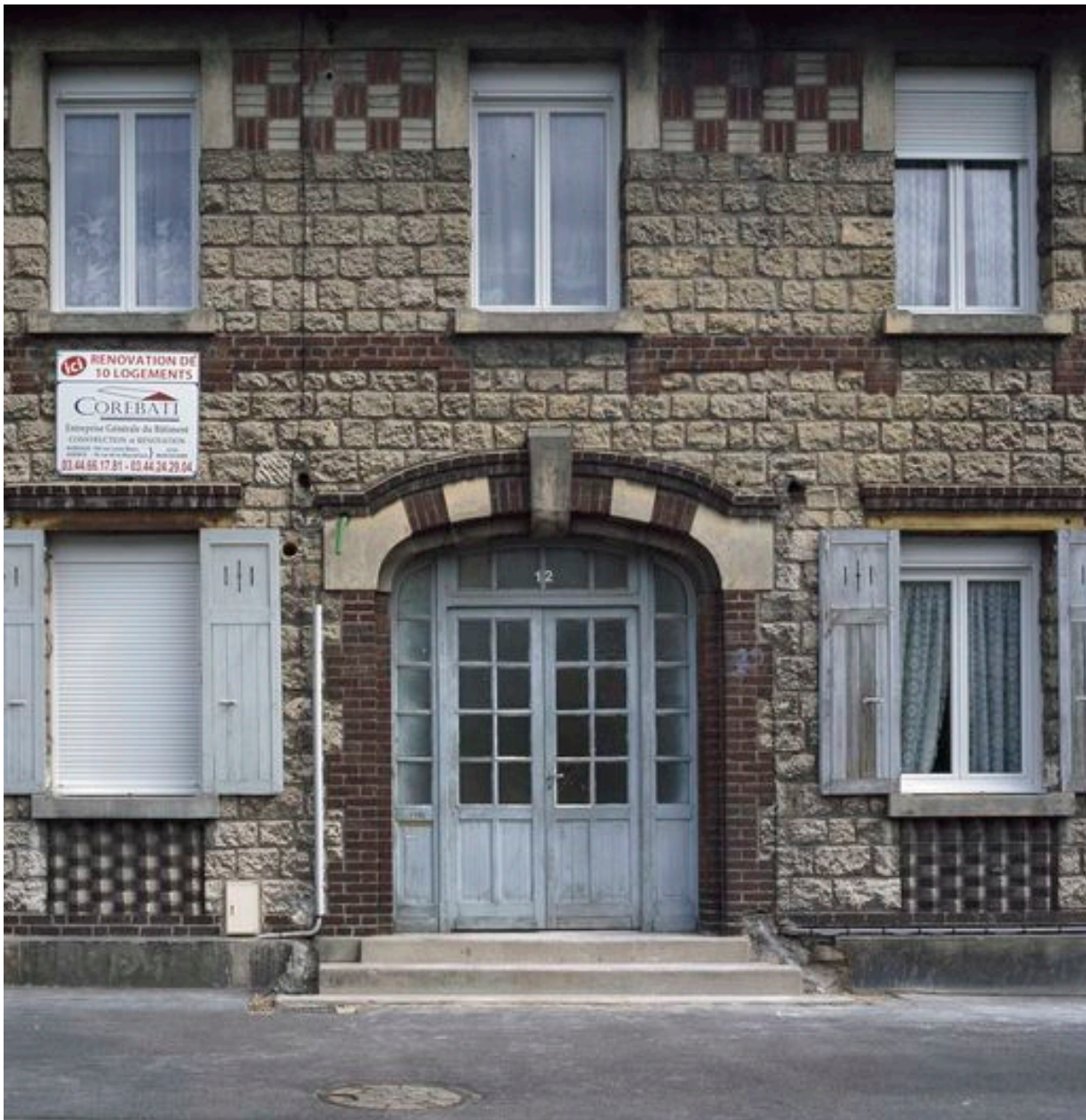
Entrée des logements.
