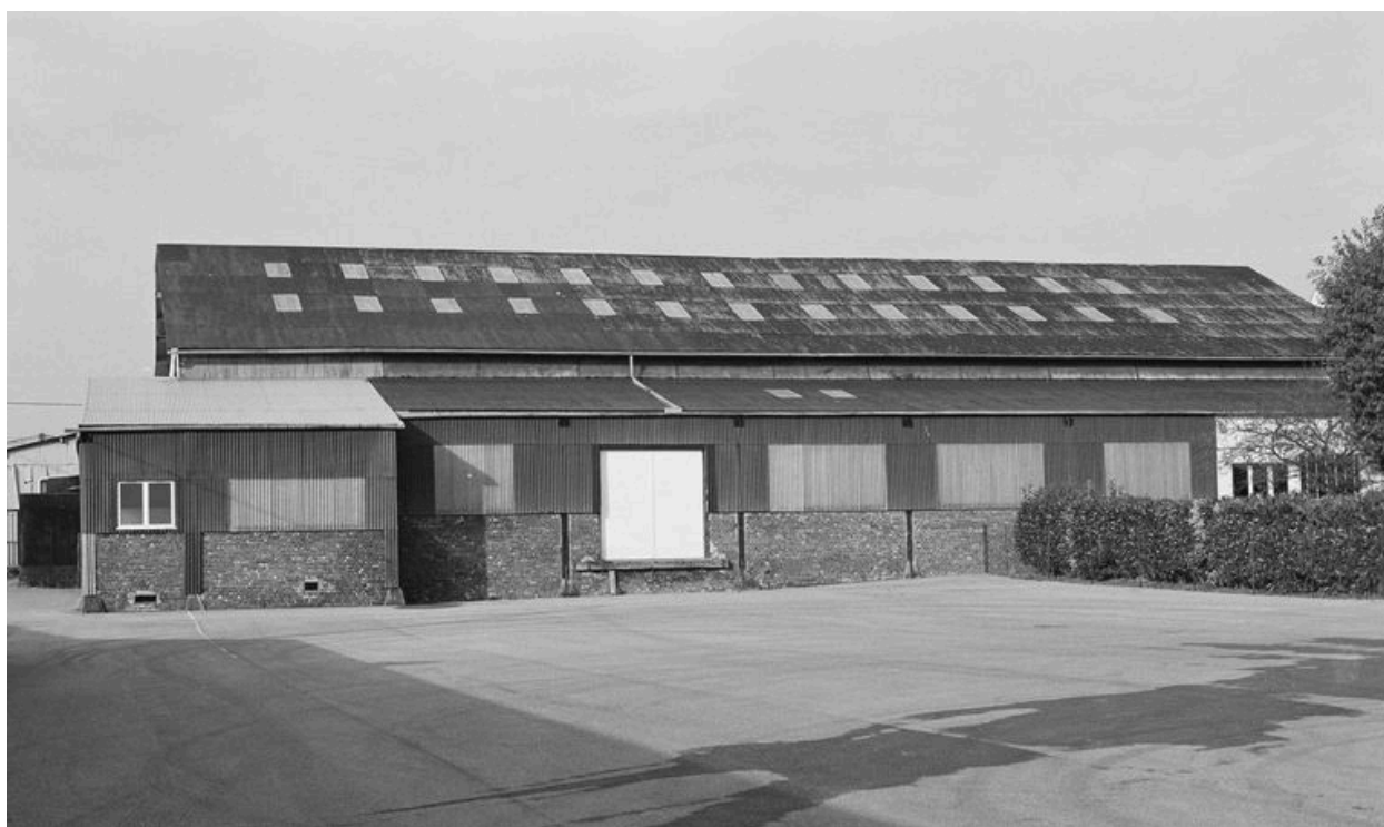
Atelier principal de sciage : façade longitudinale sud.
