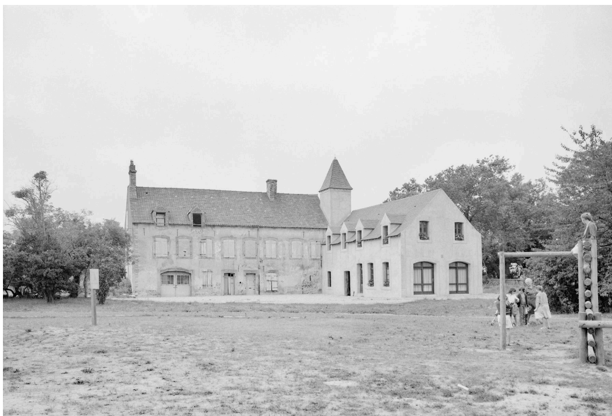
Vue générale de la demeure prise depuis le parc.
