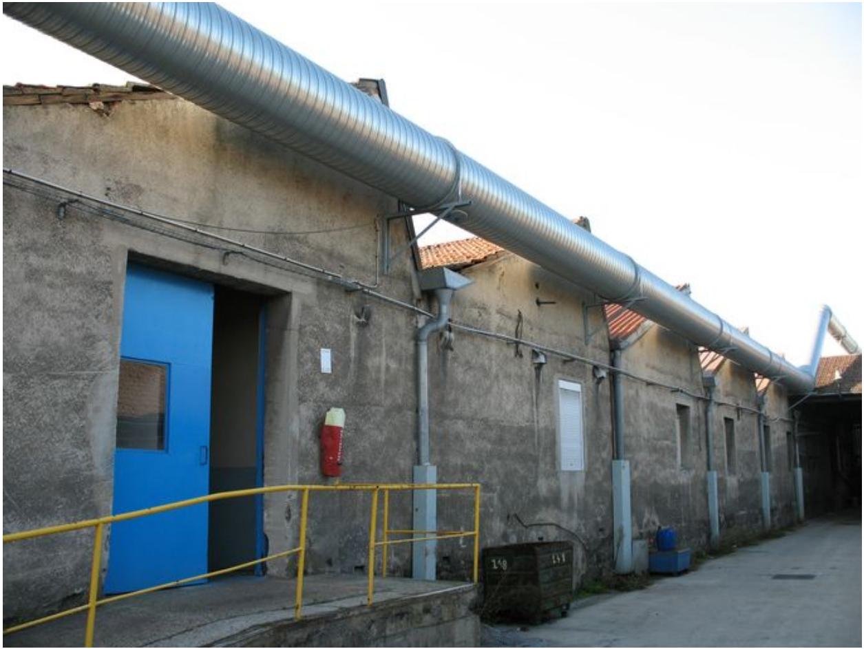
Détail des sheds.
