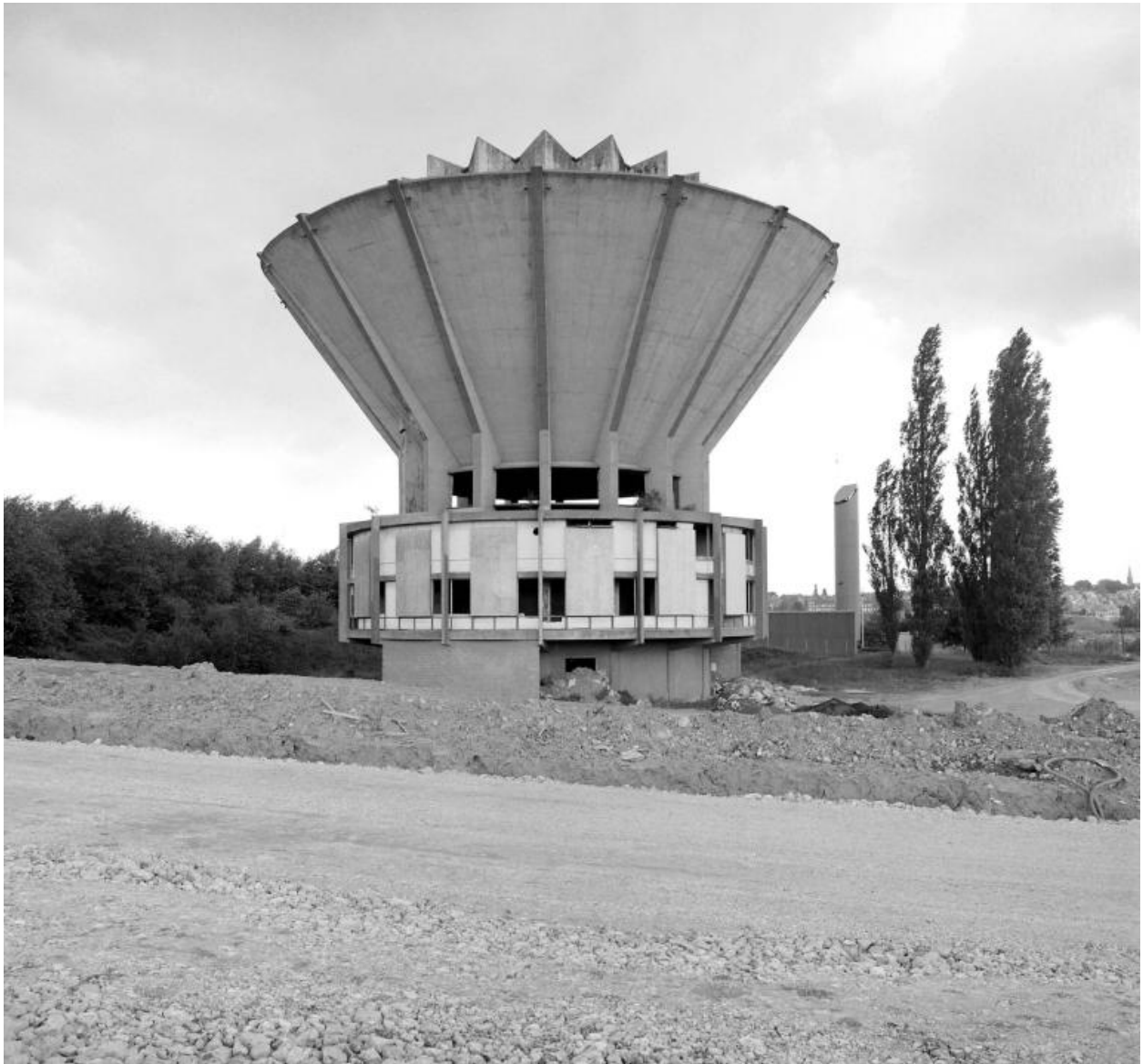
Vue générale du silo de dosage appelé le Dispatching, seul vestige de l'usine sidérurgique Usinor.
