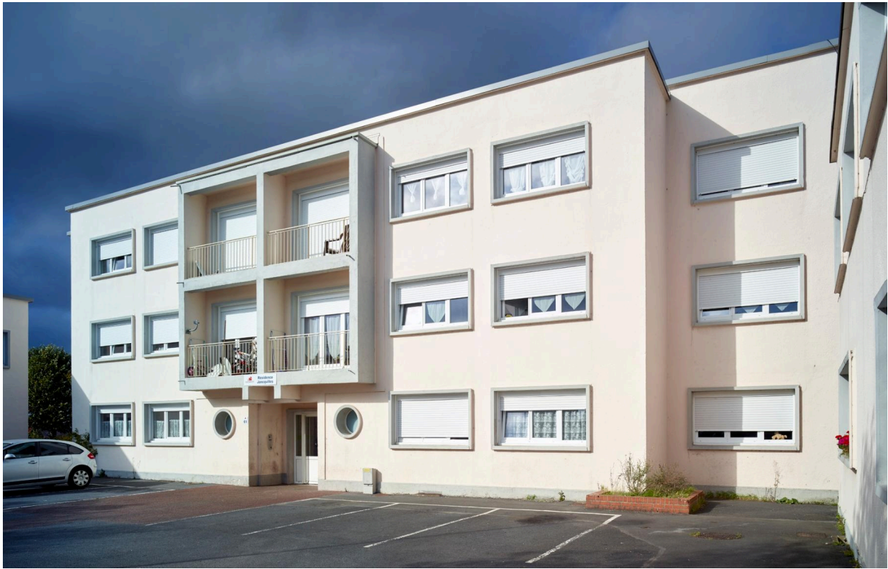
Dispositif d'entrée actuel du bloc A.
