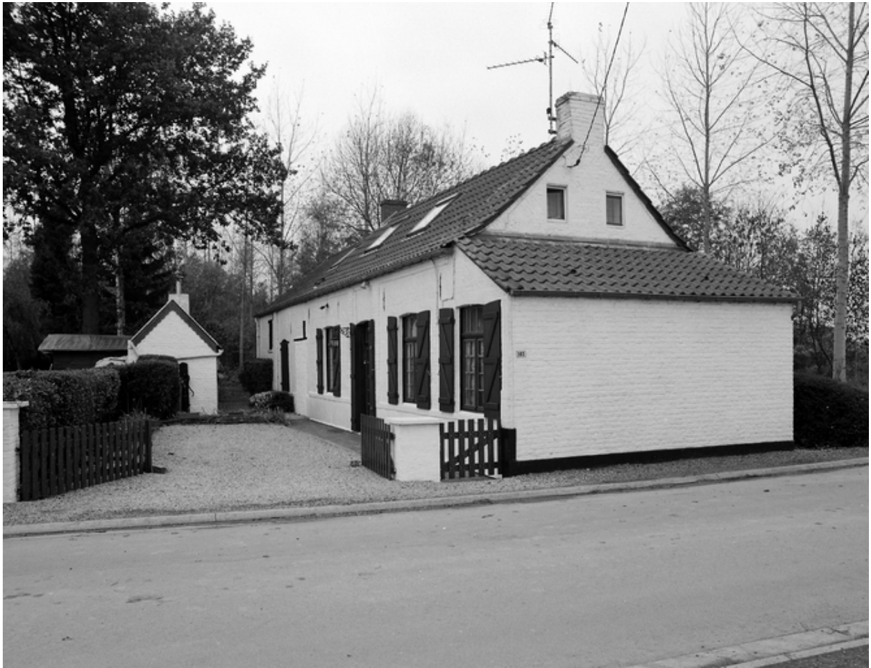
Ferme élémentaire, 583, rue Prière, logis et fournil.
