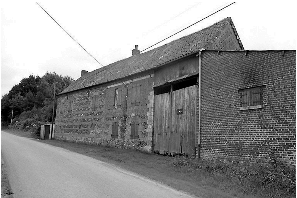
Vue depuis la rue : porche donnant accès à la cour intérieure.
